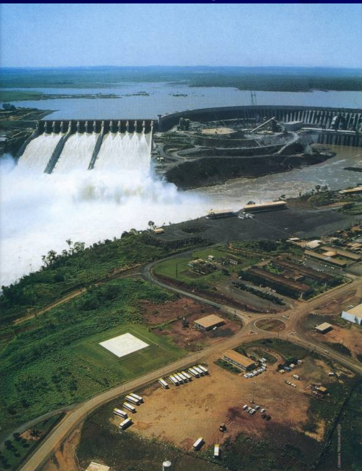
Masa wody z hukiem wpada przez główny przelew zapory Itaipu. Na prawo od przelewu widać główną betonową zaporę.
